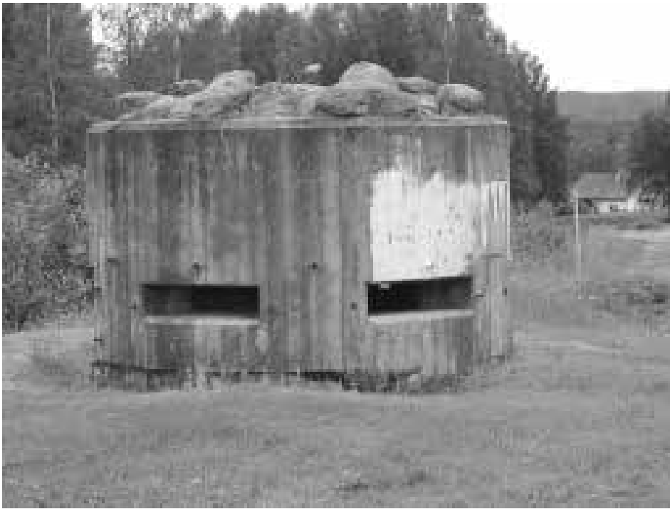
En sällsynt syn idag. Ett kulsprutevärn av typ Ksp F i Vännäs, Norrland. Värnet ligger ovanligt öppet och har ett stenmaskerat tak. Foto: Jörgen Sjöblom
