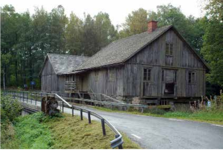
Här vid den gamla kvarnen i Gudrastorp, utanför Vittsjö, ser man fortfarande spåren av försvarsåtgärder. Kanske var detta en del av den befästningslinje -från kust till kust, som rekognoserades under slutet av 1940-talet.
