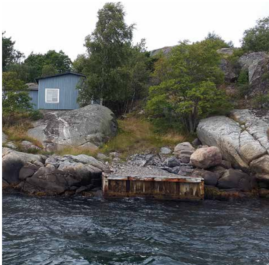
Minstation DÖ 2 vid Köpstadsö östra udde. Maskerad som sommarstuga och där periskopet var placerat innuti en plåtskorsten, numera riven. Stugan är idag i privat ägo. (foto: Magnus Emanuelsson 2015)
