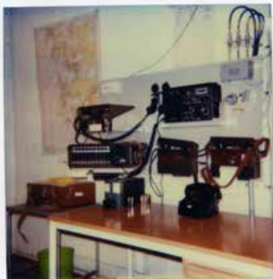
Minstation Donsö 1 (DÖ 1) Op plats. En ganska spartansk arbetsplats. Telefoner och radiokommunikationer är viktiga arbetsredskap i minstationen. På bilden syns också den vanliga fälttelefonen, även kallad "fältapa".
