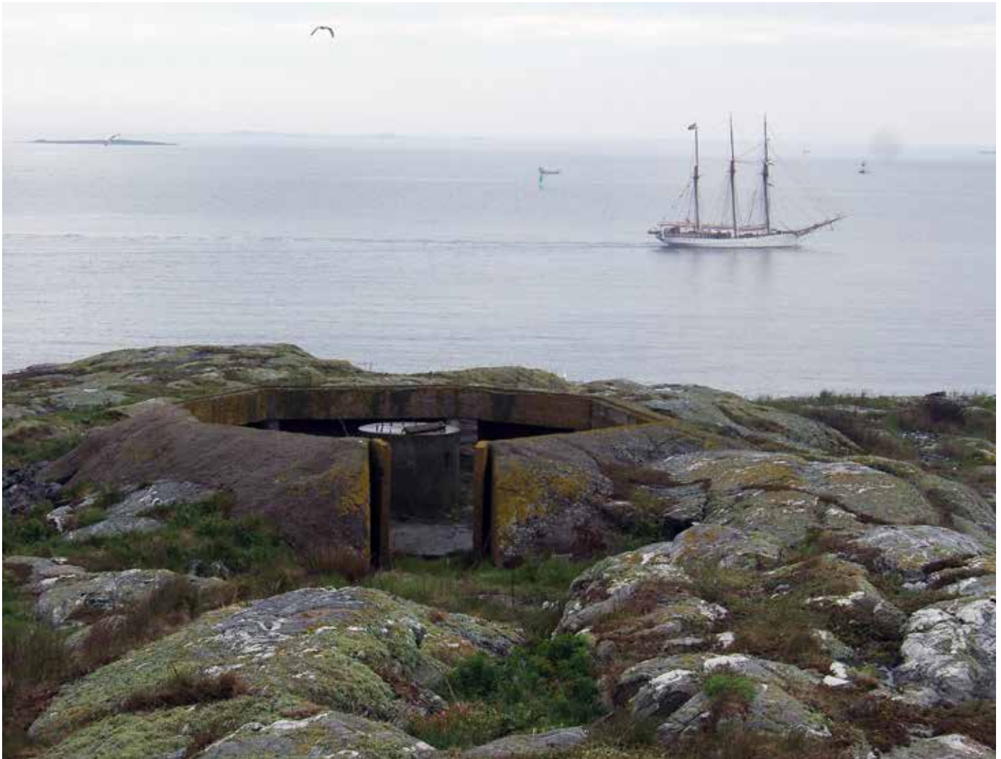
Flera minstationer hade luftvärnsskydd i form av 40 mm luftvärnskanoner. De flesta placerade i betongvärn av den modell som syns på bilden. Med sin placering nära vattnet kunde pjäserna också användas för att bekämpa mindre fartyg. (foto: Max Anjou)
