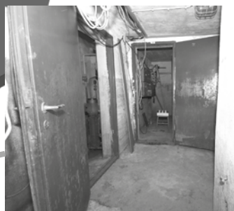
Rakt fram syns bunkerns elcentral. Två skymtar man pumprummet.
