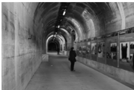
Den stora ingångstunneln till anläggningen La Coupole .
