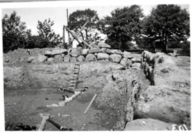
4. SK HB. Schakt o kallmur Under arbete.
