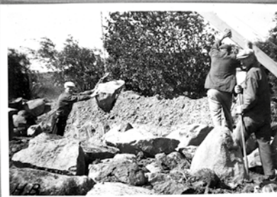
8. SK HB. Stenmantel under läggning.
