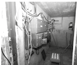
Elcentralen. Här finns också luckan ut till nödutgången, genom vilken man fick klättra upp på stegpinnar.
