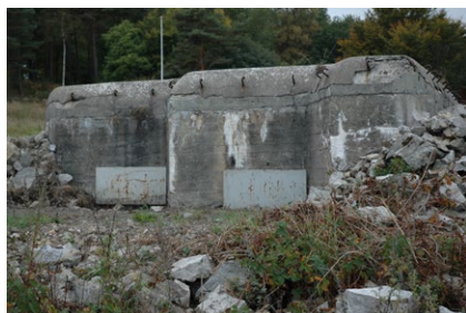
De båda embrassyrerna i ett kulsprutevärn, Ksp I. Öppningarna är täckta med en kraftig ställlucka i 19 mm järnplåt.
