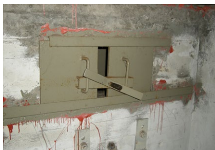
Insidan av en embrassyr. Två kraftiga plåtluckor som stänger öppningen utåt. I fredstid säkrades ytterluckorna med den kraftiga ställluckan. Denna låstes från insidan med en järnstång, fastsatt i ytterluckan, som sedan säkrades med en gängad låsbom.
