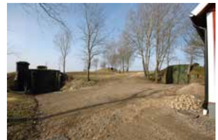
Här syns tre av de fyra ingående betongbyggnaderna på R 102. Notera stallbyggnaden till höger.
