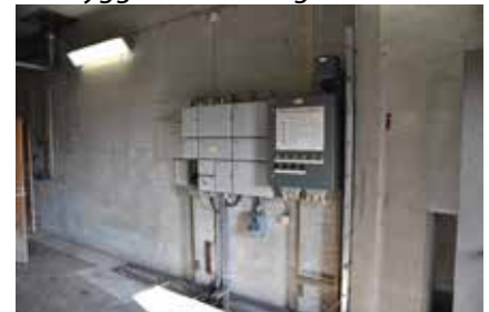
Betongvärnen genomgick också en del moderniseringar, bland annat när det gällde strömförsörjningen. De sista åren före raseringen användes anläggningen av det lokala hemvärnet.
