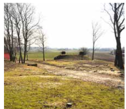
I samband med raseringen fick stora delar av trädbeståndet sågas ner för att ge plats till maskinerna.
