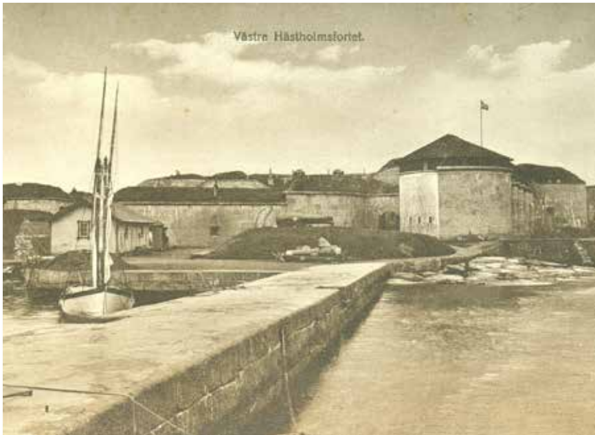
Hamnen vid Västra Hästholmen på ett vykort från 1890-talet. Mitt i bilden syns ett öppet pjäsvärn för två 24 cm kanoner m/1869, och i bakgrunden syns fortet entré samt pansarbatteriet (till höger). Idag går stora vägen till Hasslö precis framför fortet. (foto: Blekinge läns museum)
