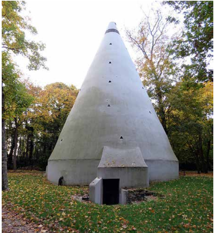
Det 18 meter höga skyddsrummet i Villenoy. (foto: Internet/Le Marne)
