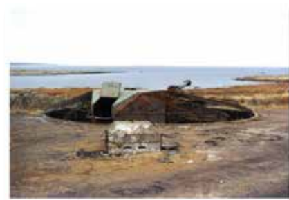
Här skärs pansarskyddet till av batteri Korsö, s 15,2 cm kanoner bort. Skrotningen skedde 2009. Ön är fortfarande dock militärt område.
