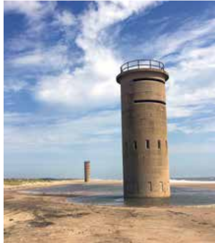
Eldledningstorn (foto: Terry McGovern) batteri Smith.
